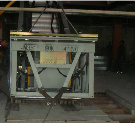
Figura 3 - copertura fossa con tavole e cristi di sostegno calcolati per supportare il peso
